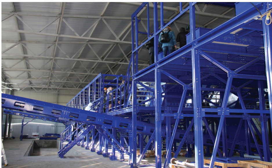
Рис. 13.3. Мусоросортировочный комплекс на территории г. Волжский
