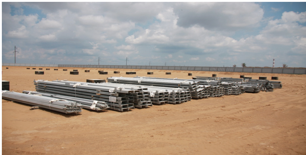
Рис. 13.2. Строительство мусороперерабатывающего комплекса на территории Светлоярского муниципального района Волгоградской области
